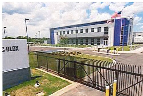
DC BLOX Birmingham, AL
